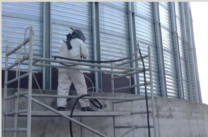
Betonsanierung & Rissverpressung der Außenfassade und Silofundamente · Verpressung, Vergelung
